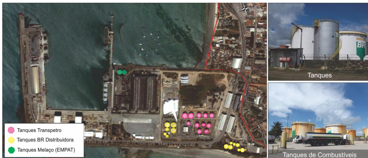
Figura 7. Tanques do Porto de Maceió
