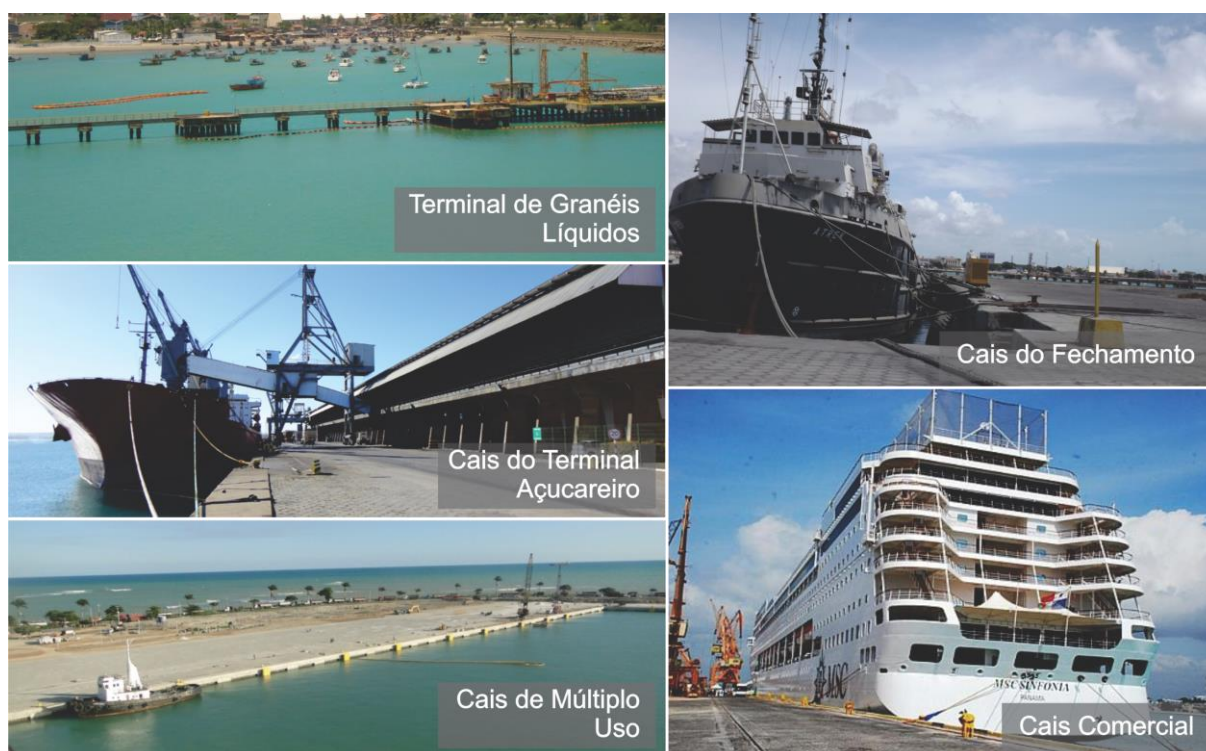
Figura 5. Trechos de Cais do Porto de Maceió
