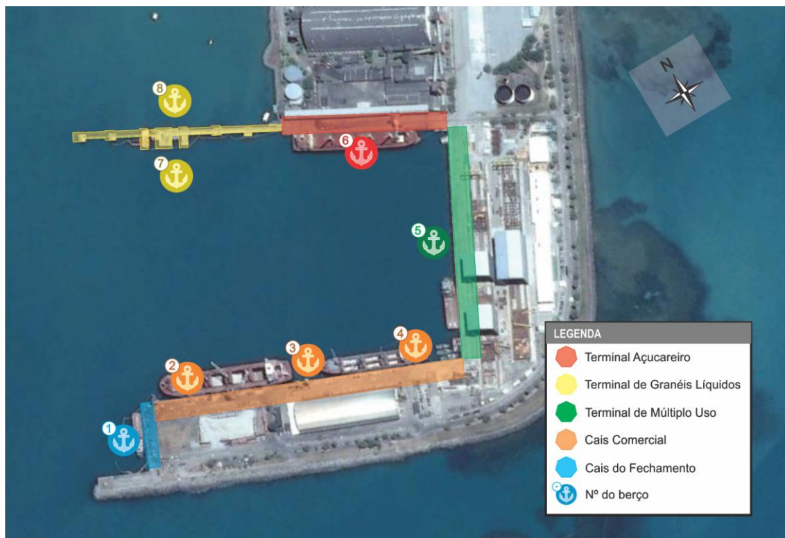
Figura 4. Infraestrutura de Acostagem do Porto de Maceió
