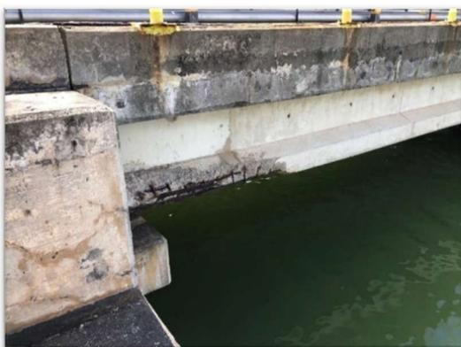
Figura 86 – Registro de Armadura Exposta no Berço 6
