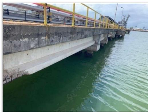
Figura 87 – Registro de Armadura Exposta no Berço 6
